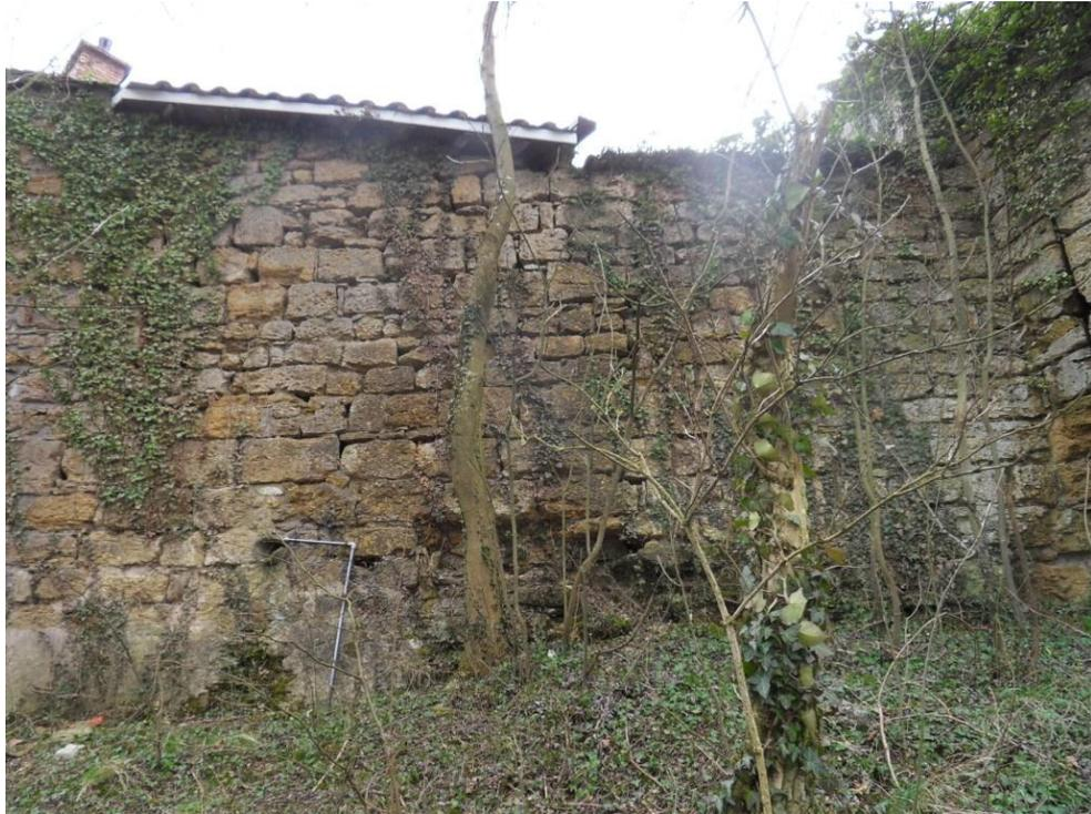
**Photo 15 : Sous-cavage en pied de mur.**
