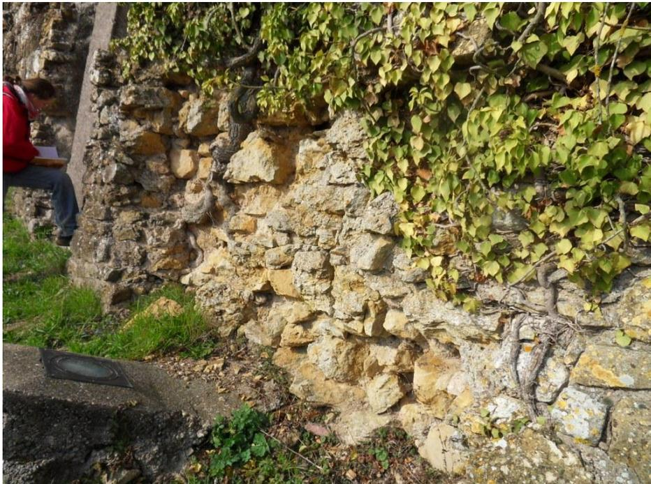
Photo 1 : Partie basse du mur et sous cavages.
