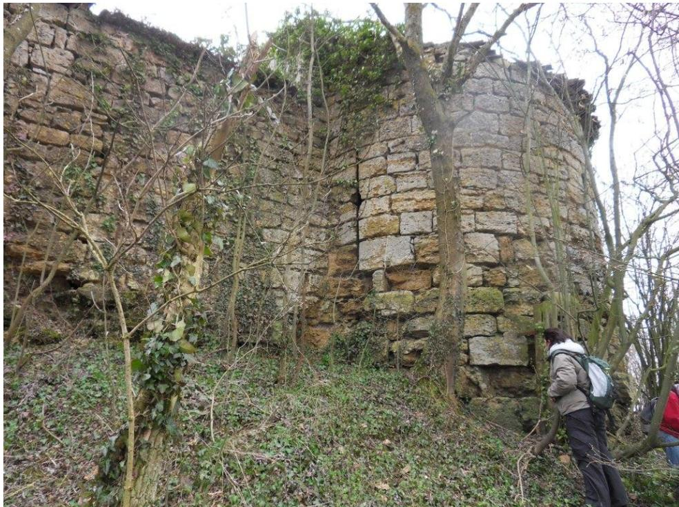
**Photo 16 : Légère altération des blocs au pied de la tour qui entraîne des sous-cavages ;
