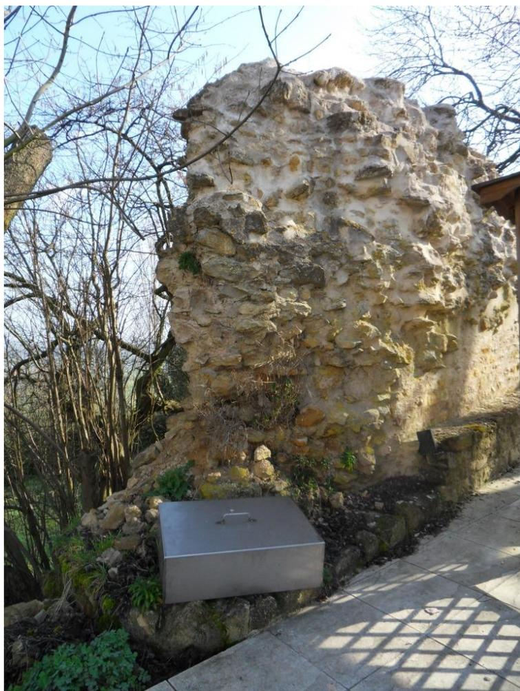
**Photo 2 : Détail du mur. On voit ici qu'il est entretenu régulièrement car les joints entre les blocs sont cimentés.**
