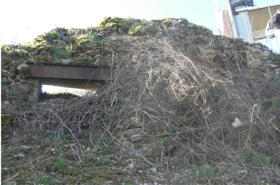
**Photo 2 : Vue générale du mur avec ouverture confortée.**
