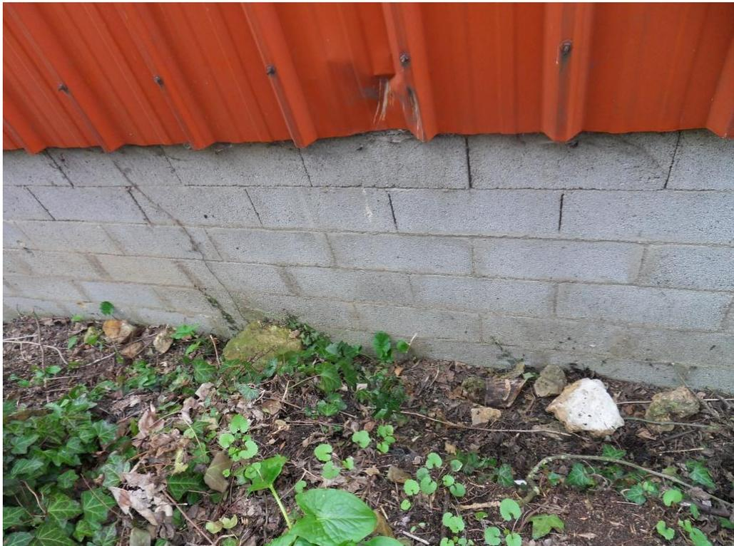
**Photo 4 : Traces d'impact de blocs sur le hangar situé en contrebas de la zone de propagation.**
