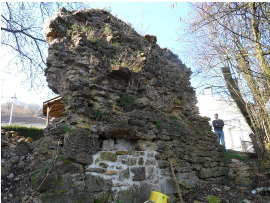
**Photo 1 : Partie du mur où on voit les blocs instables ainsi que la partie basse sous-cavée comblée par de la maçonnerie.**
