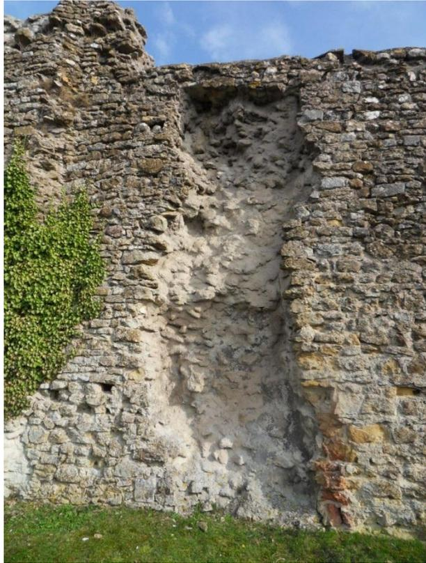
**Photo 2 : Vue des confortements intérieurs (béton projeté).**
