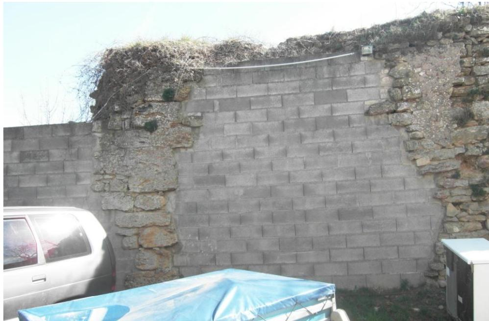
Photo 1 : Vue sur l'ouvrage en maçonnerie pour assurer la stabilité du mur.
