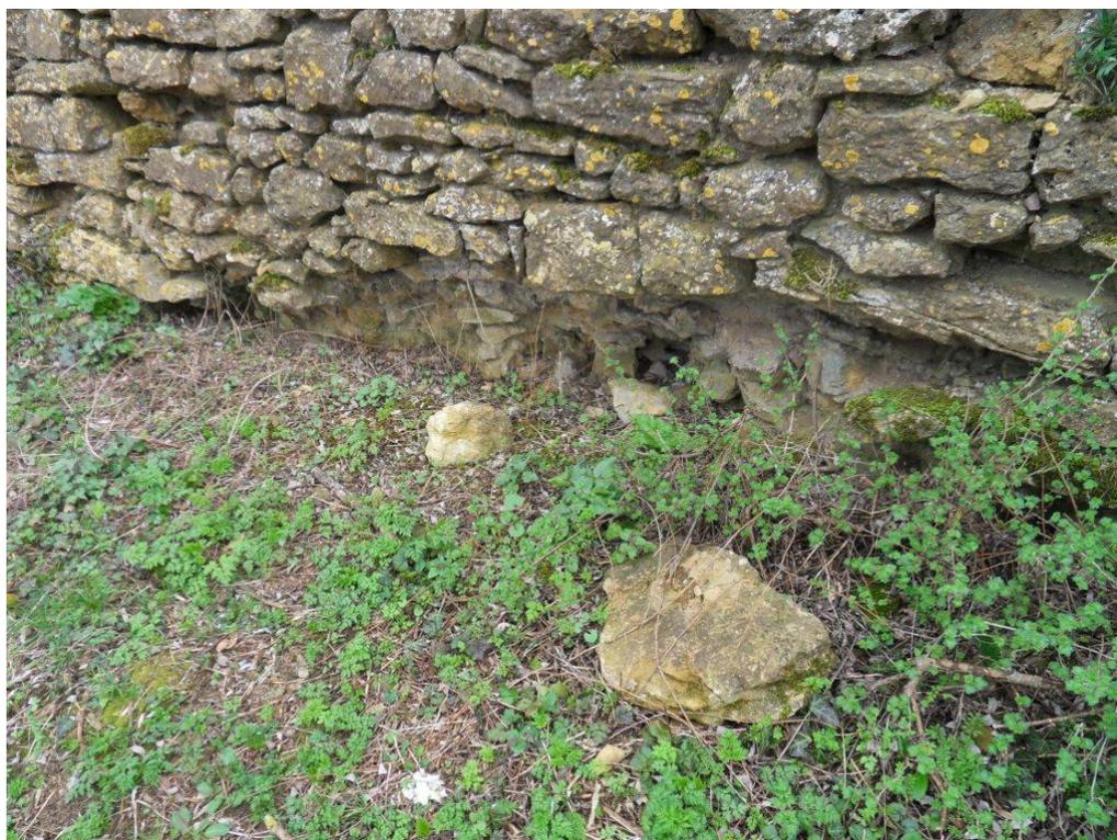
**Photo 4 : Gros plan sur un sous-cavage de la partie SW extérieure.**
